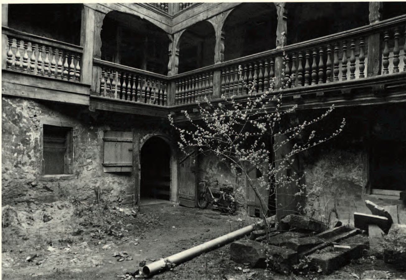
Innenhof vor der Restaurierung
