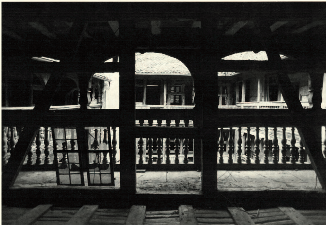
Vor der Restaurierung
